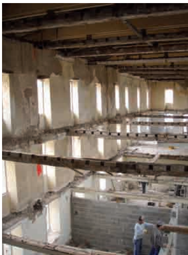
Fig. 17 Renforcement des structures intérieures.
