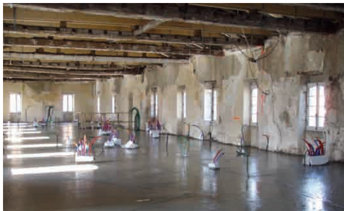
Fig. 18 Coulage des dalles de renforcement des planchers.
