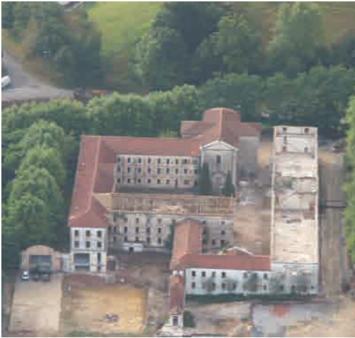
Fig. 15 Vue aérienne lors des réfections des charpentes.
