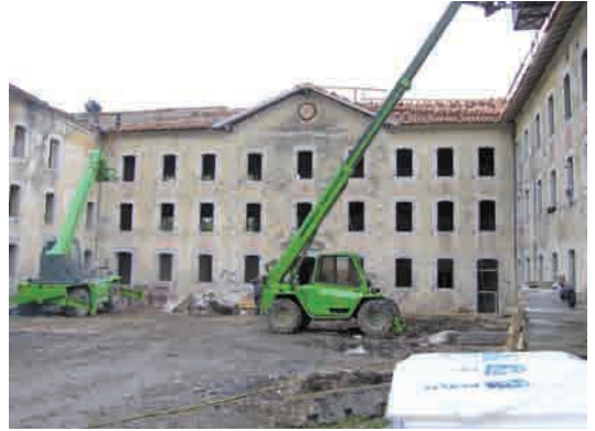
Fig. 16 Toiture et zinguerie en cours de réfection et couvertures.
