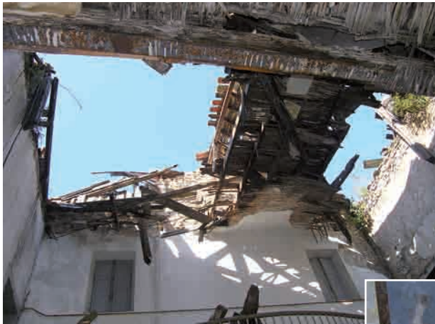
Fig. 5 État de l'aile ouest de 1860 en 2005. Les toitures s'effondrent.
