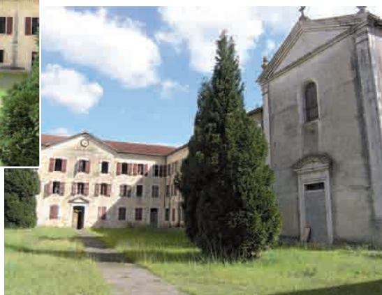
Fig. 2 Bâtiment central de 1734 et chapelle de 1828.
