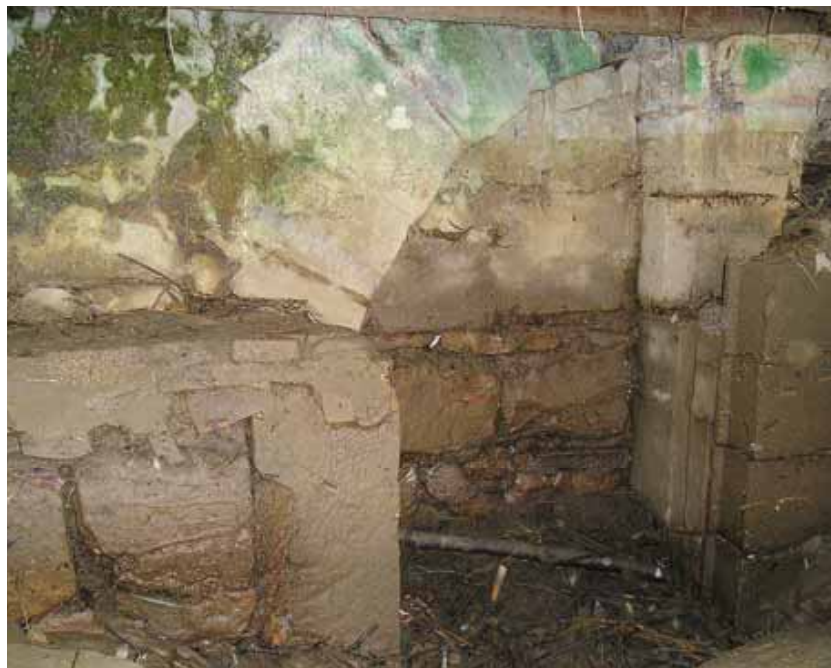
Fig. 9 : Le mur nord-est est double. Nous pouvons noter la présence d'un départ de voûte totalement obstrué avec des claveaux en pierre de taille. Devant, un mur en pierre de taille avec des joints de ligne rectiligne. (Cliché personnel).
