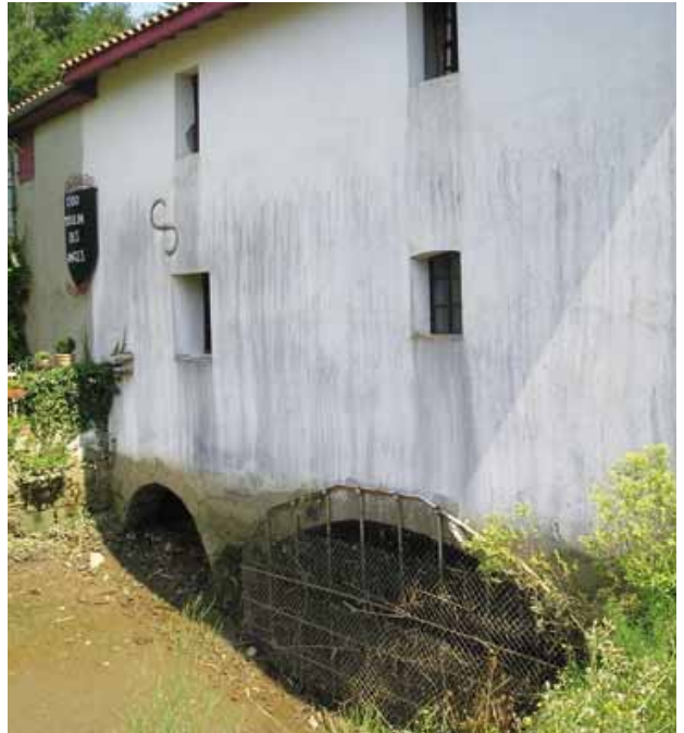
Fig. 6 : Moulin à marée de Saint-Bernard en août 2007. (Cliché personnel).
