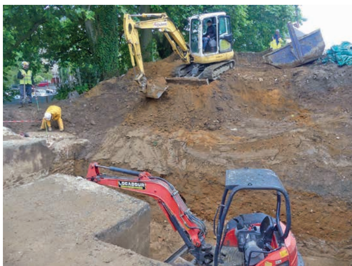
Fig. 3 Stratégie de terrassement et d'extraction des déblais vers la zone de stockage intermédiaire. Cliché de Q. Baril, Hadès.
