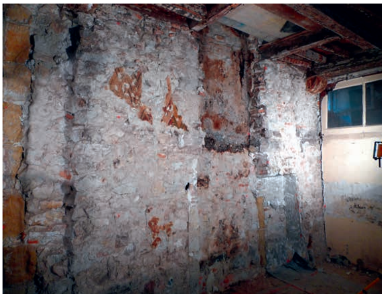
Fig. 5b Mur sud au premier étage : paroi B © J.-P. Fourdrin, 2016.
