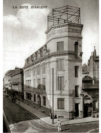
Fig. 6 À droite de l'hôtel des postes, la maison du 7 rue F.-Bastiat (1912-1918) Cliché : de Neudrin.
