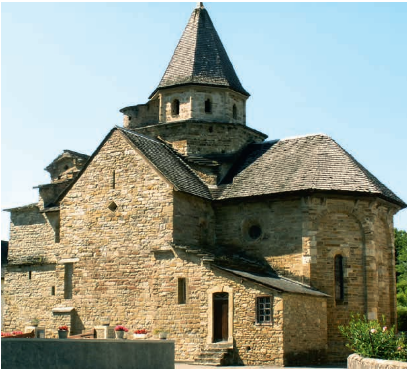
Fig. 4 Église de l'Hôpital-Saint-Blaise vue depuis le sud-est, chevet polygonal.
