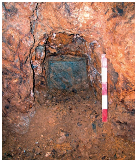
Fig. 5 Encoche de logement d'une poutre de forte section, probablement façonnée au XVIII e siècle. © J.-B. Feillou, G. Parent.
