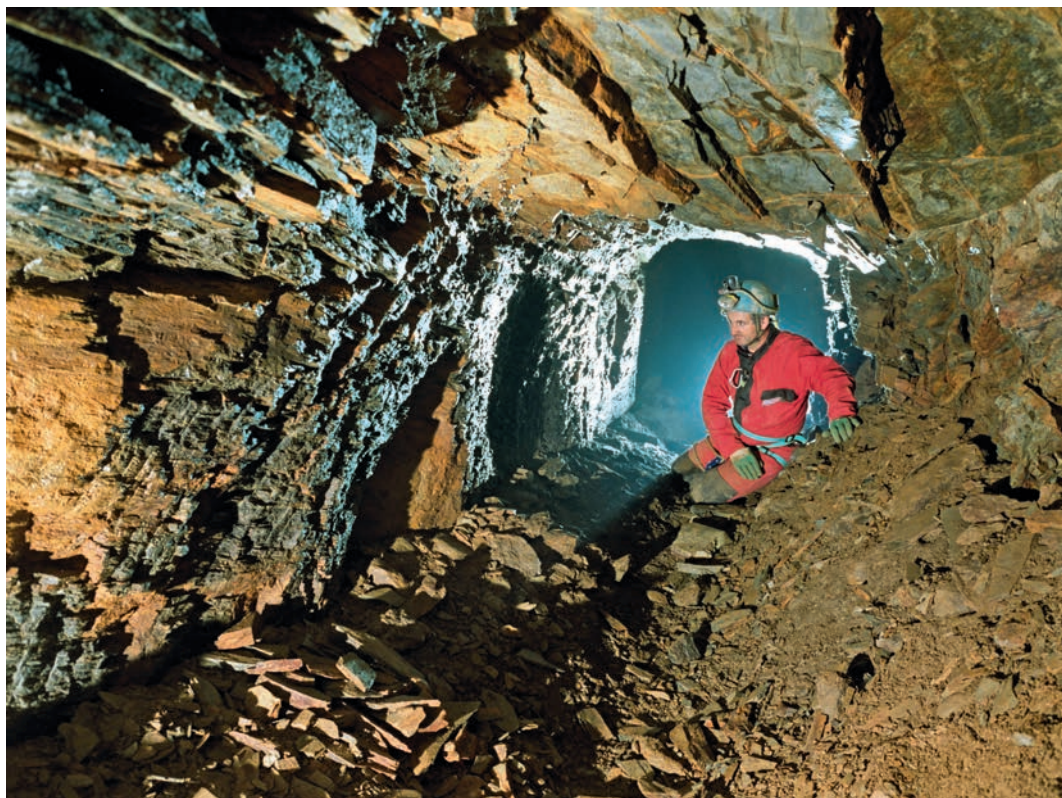
Fig. 7 Partie dégradée de la galerie creusée parallèlement au filon. © J.-B. Feillou, G. Parent, S. Planés.
