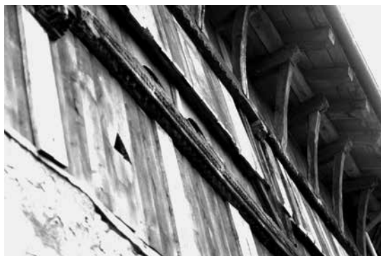
Fig. 4a Avant-toit du jauregizahar conforme à celui de l'église romane d'Ainhoa (Duvert, 2013 a).
