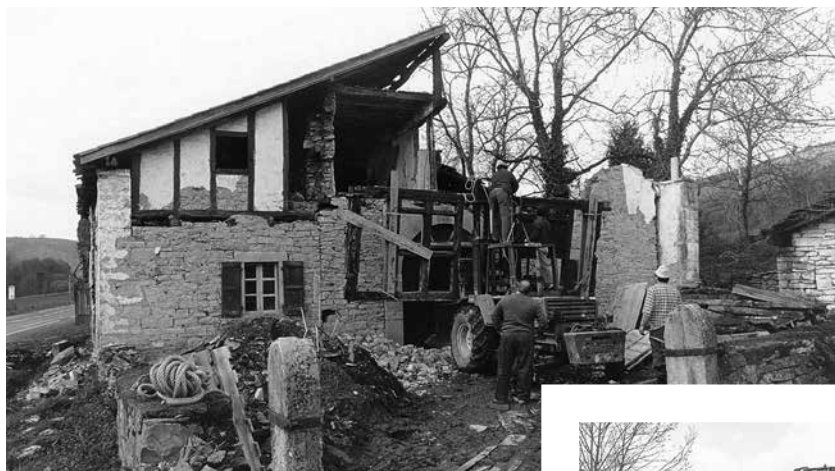
Fig. 1 Démontage du pan de bois de la façade du premier étage de la maison Pagoileta. Musée Basque et de l'histoire de Bayonne, Cliché B. Chassevent.
