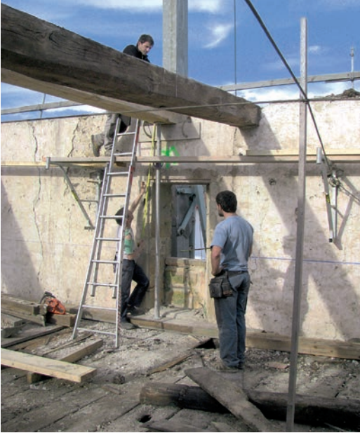
Fig. 3f Les jeunes charpentiers de notre époque se démarquent des techniques anciennes ; ils ont forcément une autre approche de leur art. Ici ils changent une poutre dans un ancien jauregi (Labour).
