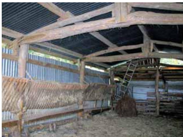
Fig. 10 Cette ardirborda récente, à ossature de bois, a été édifée dans une zone riche en vestiges pastoraux anciens.
