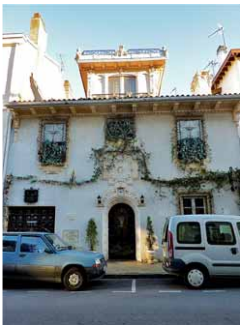
Fig. 6 Bayonne : façade de la casa Nicasio Cirilo avec le médaillon du propriétaire constructeur.
