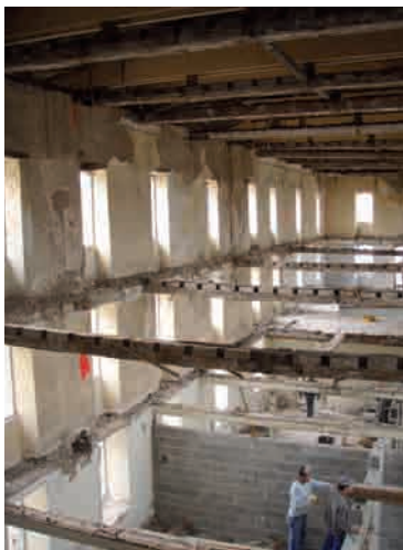
Fig. 17 Renforcement des structures intérieures.
