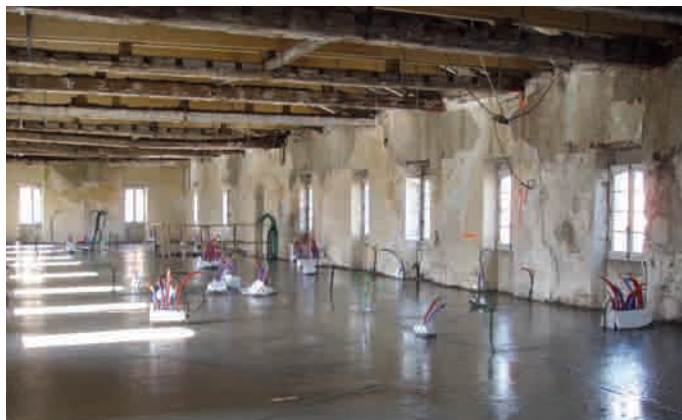
Fig. 18 Coulage des dalles de renforcement des planchers.
