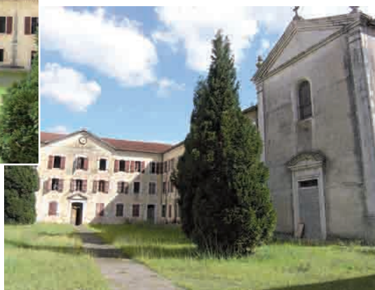
Fig. 2 Bâtiment central de 1734 et chapelle de 1828.
