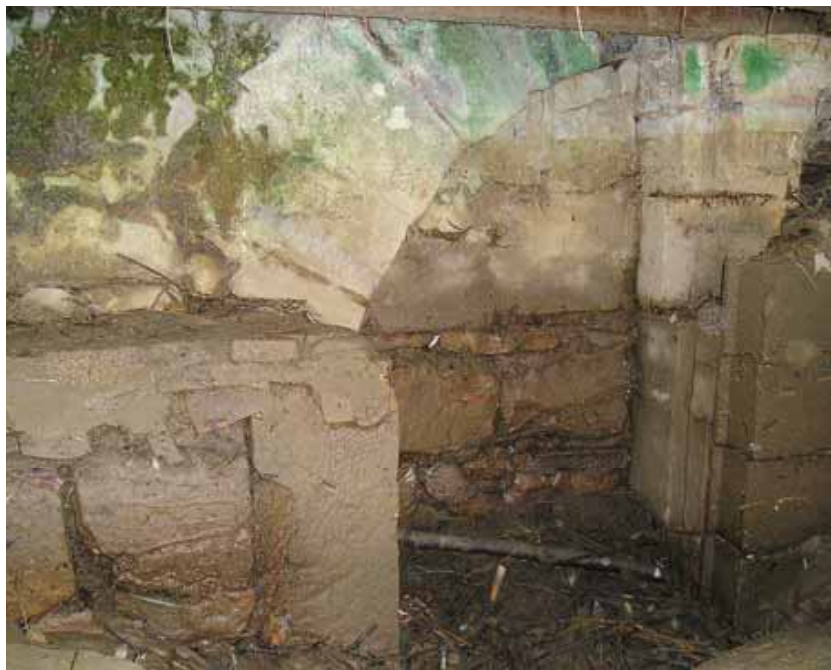
Fig. 9 : Le mur nord-est est double. Nous pouvons noter la présence d'un départ de voûte totalement obstrué avec des claveaux en pierre de taille. Devant, un mur en pierre de taille avec des joints de ligne rectiligne. (Cliché personnel).
