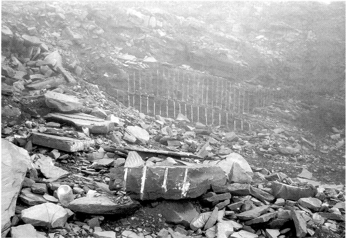
Fig. 6A : front de taille, traces des forages ayant servi à détacher les blocs.
