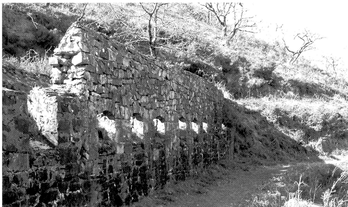
Fig. 2 - Trémie et voie de roulage du XX e siècle.
